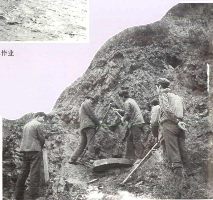
测绘队员埋设测量标志
