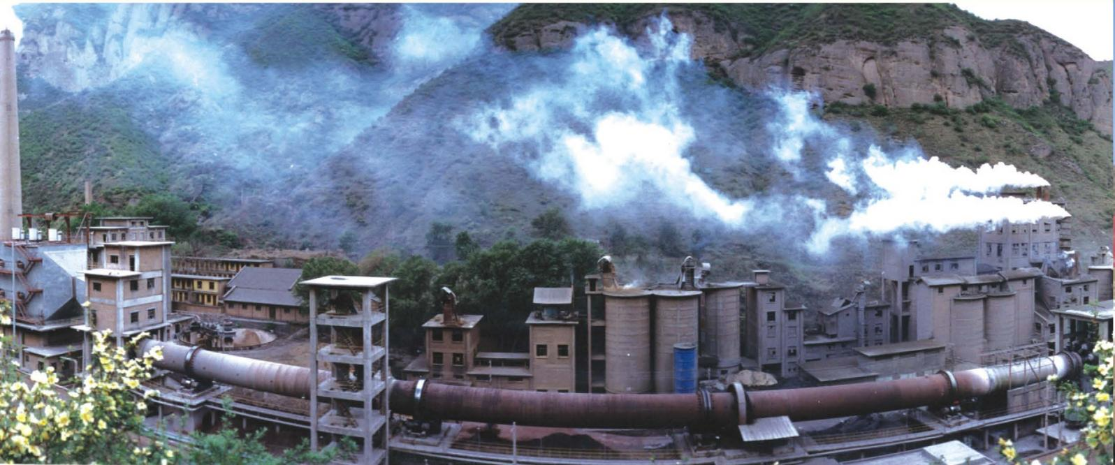
1998年建成投产的平凉峡中水泥厂直径3.5×125米回转窑生产线
