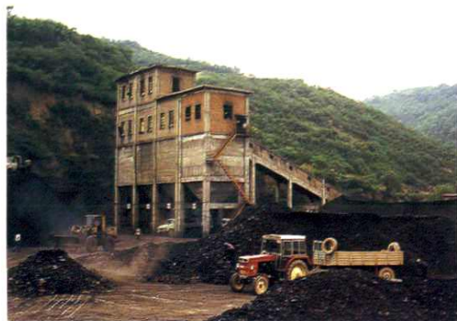
庆阳地区净石沟煤矿选煤楼
