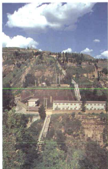
巴家嘴电灌工程上水管道
