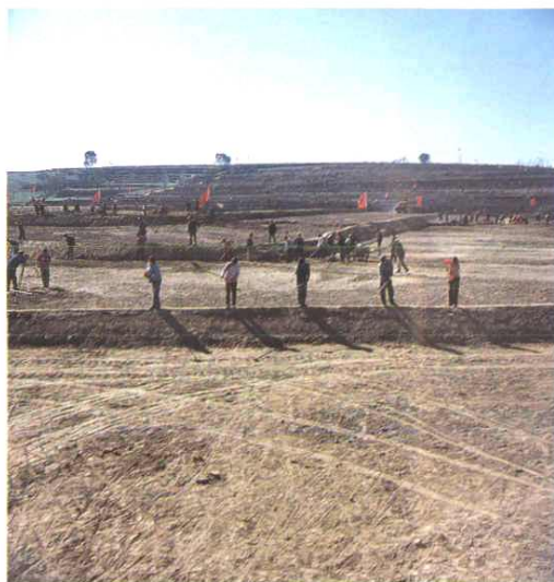
宁县新庄农田基本建设工地(1982年摄)
