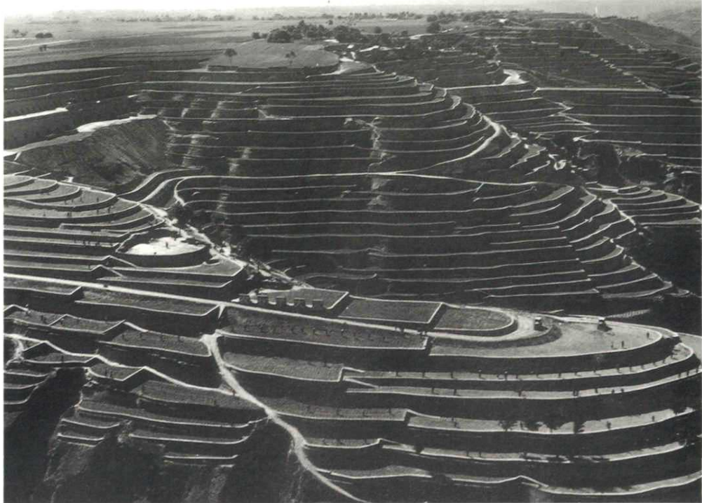
宁县焦村公社烂泥沟梯田(1976年摄)
