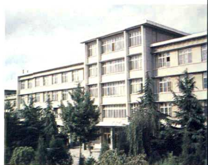
黄委会西峰水土保持 科学试验站办公楼
