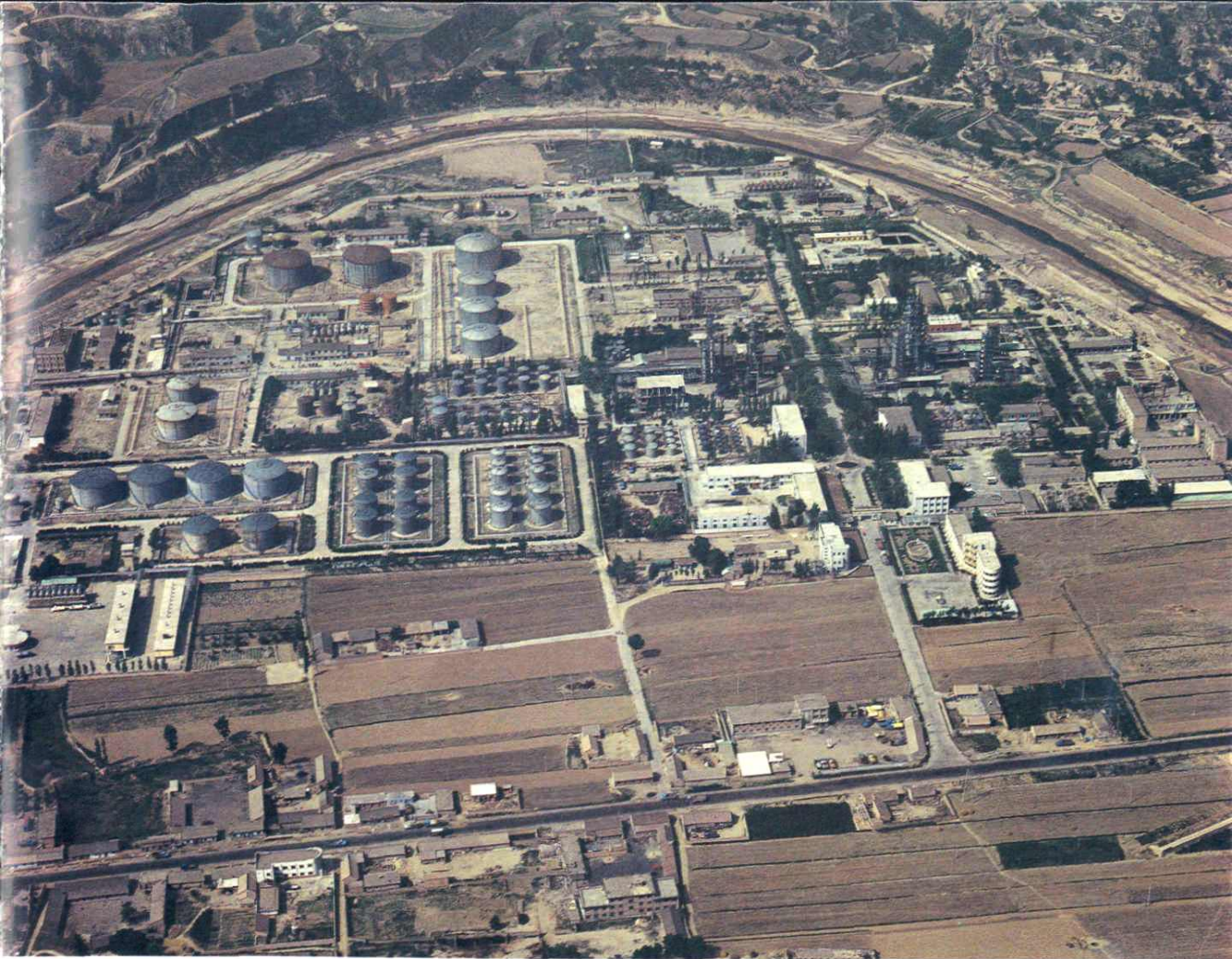
长庆石油勘探局马岭炼油厂
