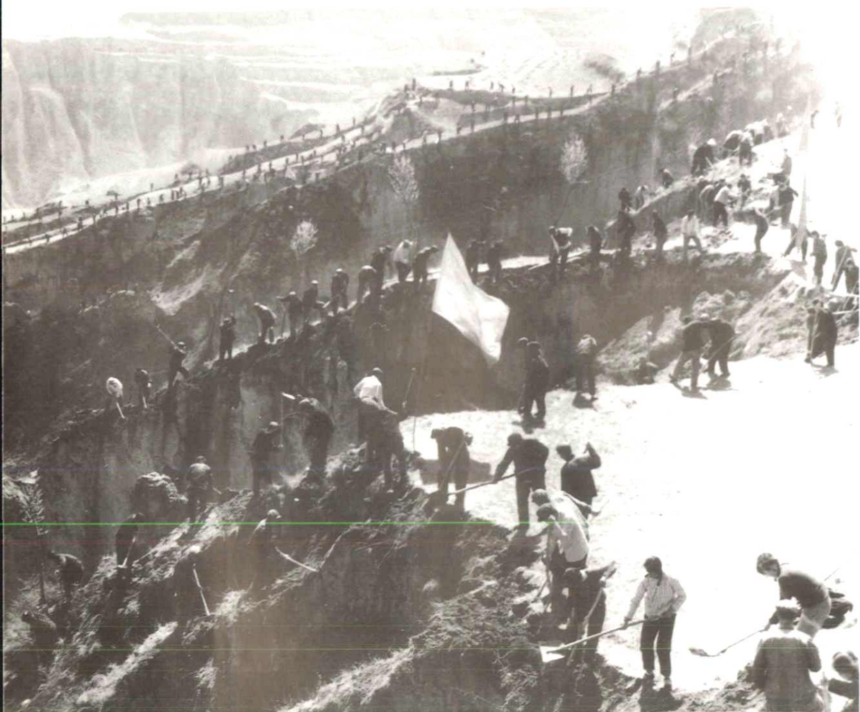
正宁县西坡公社五畔村农田基本建设工地(1972年摄)
