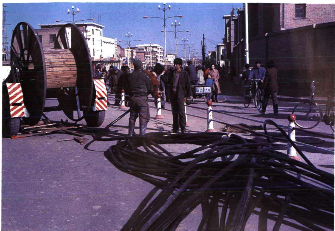
铺设地下电缆
