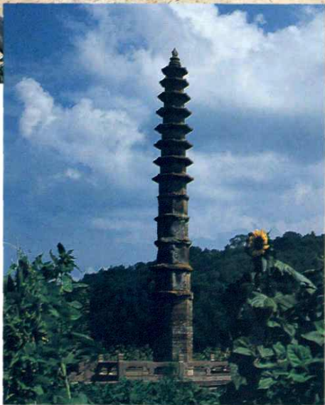
合水塔儿湾石塔
