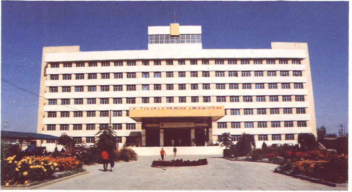
武威市人民政府办公楼
