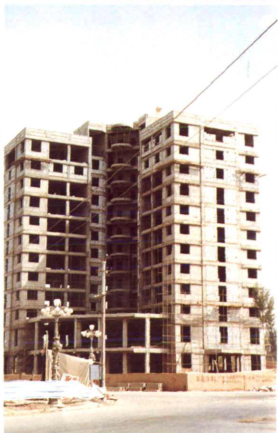
金羊建筑公司施工现场
