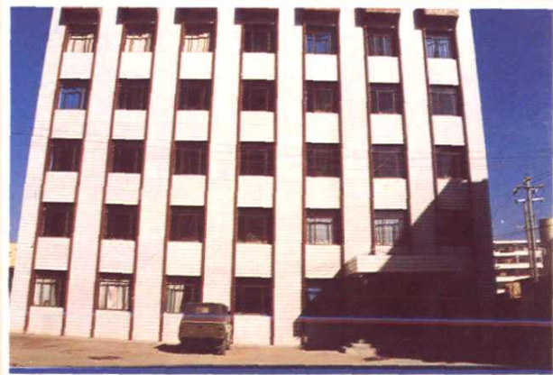
市武装部办公楼
