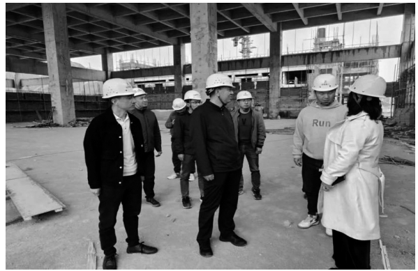
2023 年，州地震局督查重点建设项目抗震设防情况
