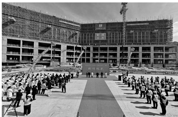
2023年4月28日，夏河县医院综合楼项目（一期）工程主楼封顶并举行封顶仪式
