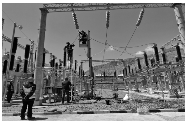
2023年5月6日，国网甘南供电公司组织人员在110千伏多宋多变电站开展间隔施工，保障“西成铁路”施工点供电
