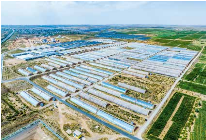
图 27 2023 年 8 月,古浪县千城乡富民新村日光温室产业区 (甘曜毓 摄)
