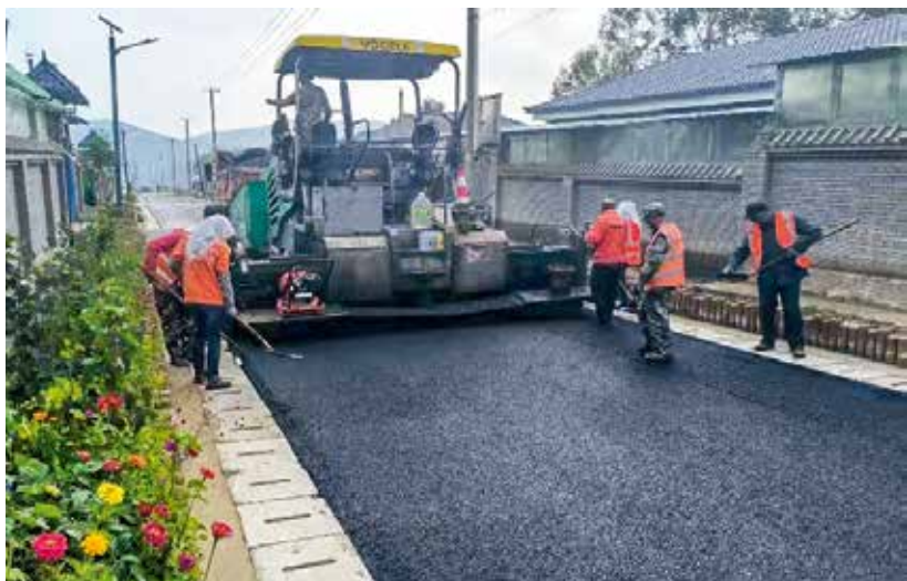
图 57 2023 年 10 月，天祝县乡村道路施工现场
