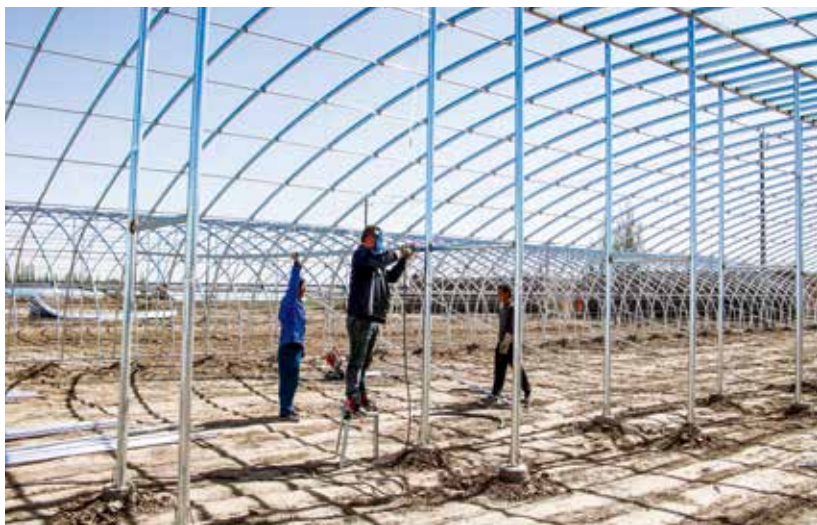
图 34 2023 年 4 月,凉州区高坝镇蔡家村现代农业产业园内,工人正在搭建双面日光温室 (王瑾 赵东晓 摄)
