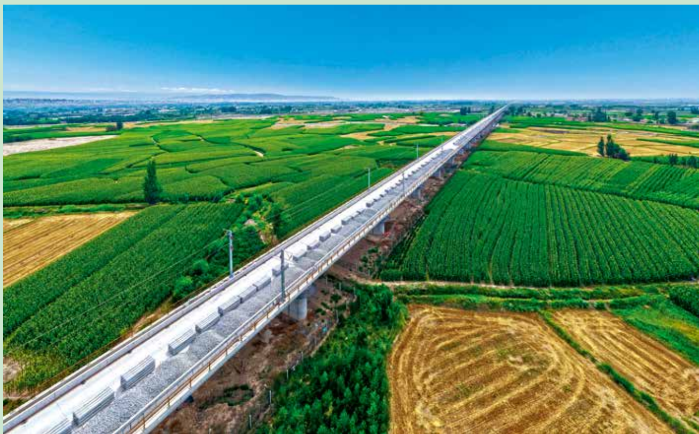
2023年8月,正在建设中的兰张三四线铁路中川机场至武威段
