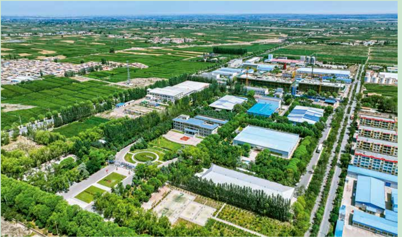
2023年7月,甘肃普安制药有限公司年产5000万盒宣肺止咳合剂生产线升级改造项目现场
