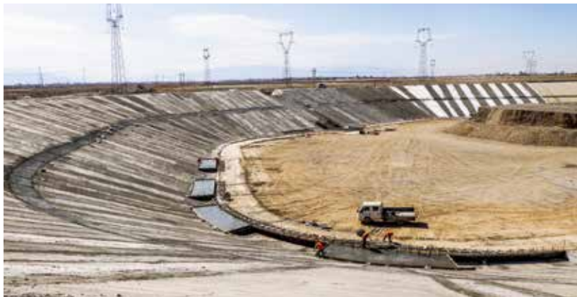
图 36 2023 年 3 月，凉州区调蓄工程建设现场（王丽 杨宝 摄）
