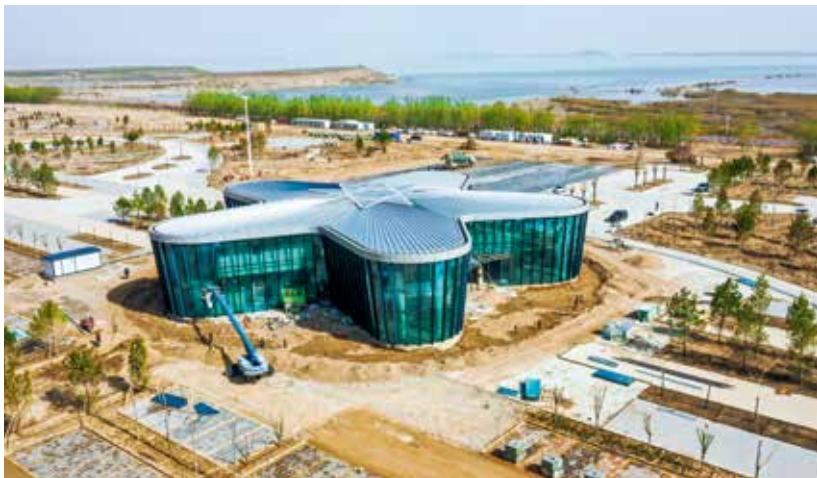
图 46 2023 年 5 月,民勤通航乐园项目建设现场 (李政阳 赵东晓 摄)
