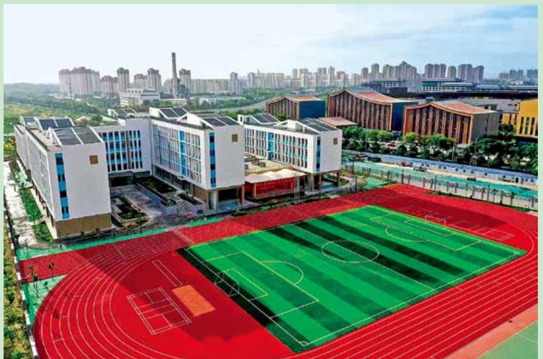
2023年7月,武威第二十一中学改扩建项目
