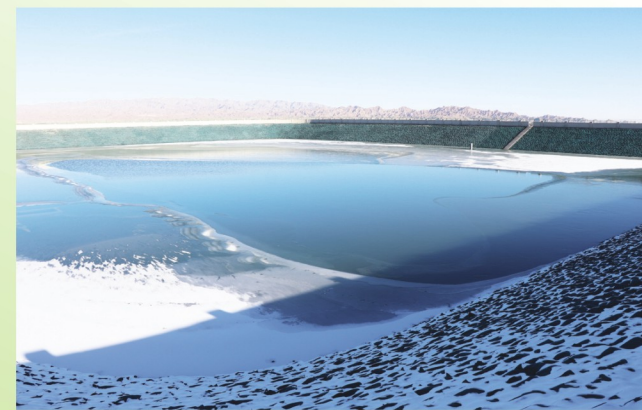
菁茂农业8万立方米蓄水池
