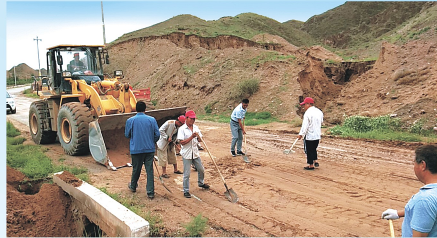
交运人员抢修水毁道路
