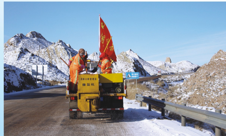
公路段养护工人撒布融雪盐
