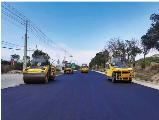
G212线养护工程施工现场
