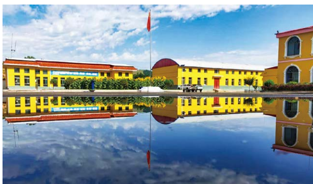
临洮县南部水厂
