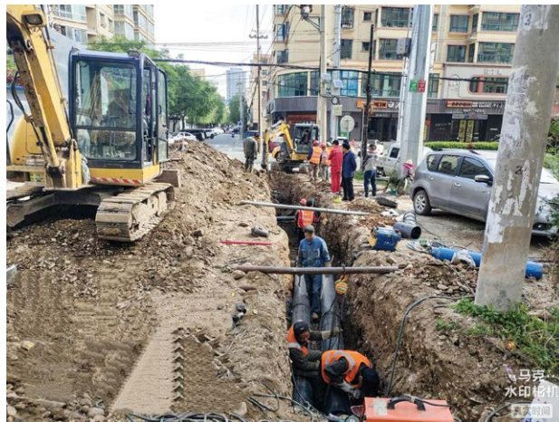
南苑小区供热管网改造
