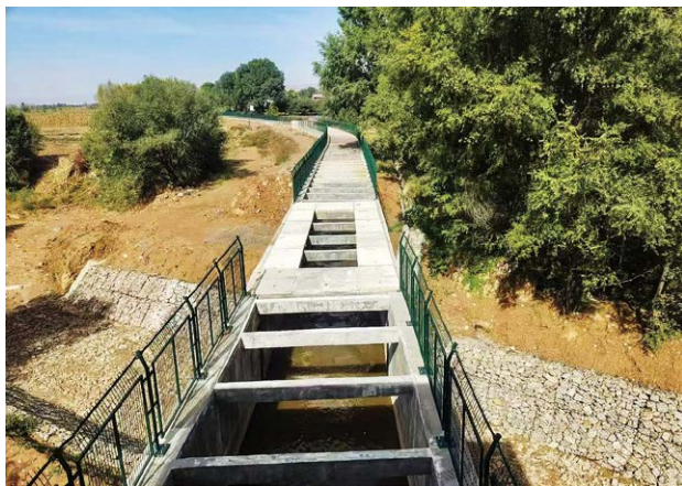
临洮县洮河灌区（大型）续建配套与现代化改造项目建设完成后的洮惠渠钢筋混凝土矩形渠
