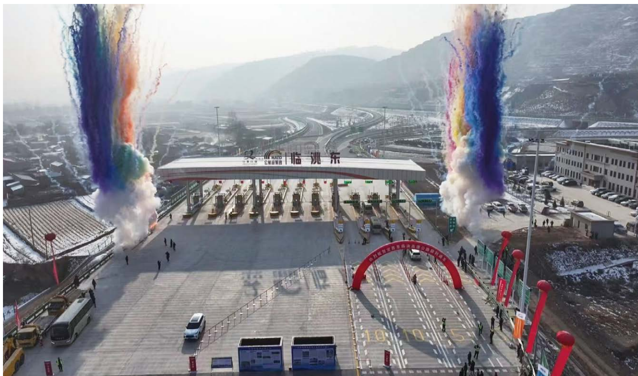
定临高速龙门段正式通车
