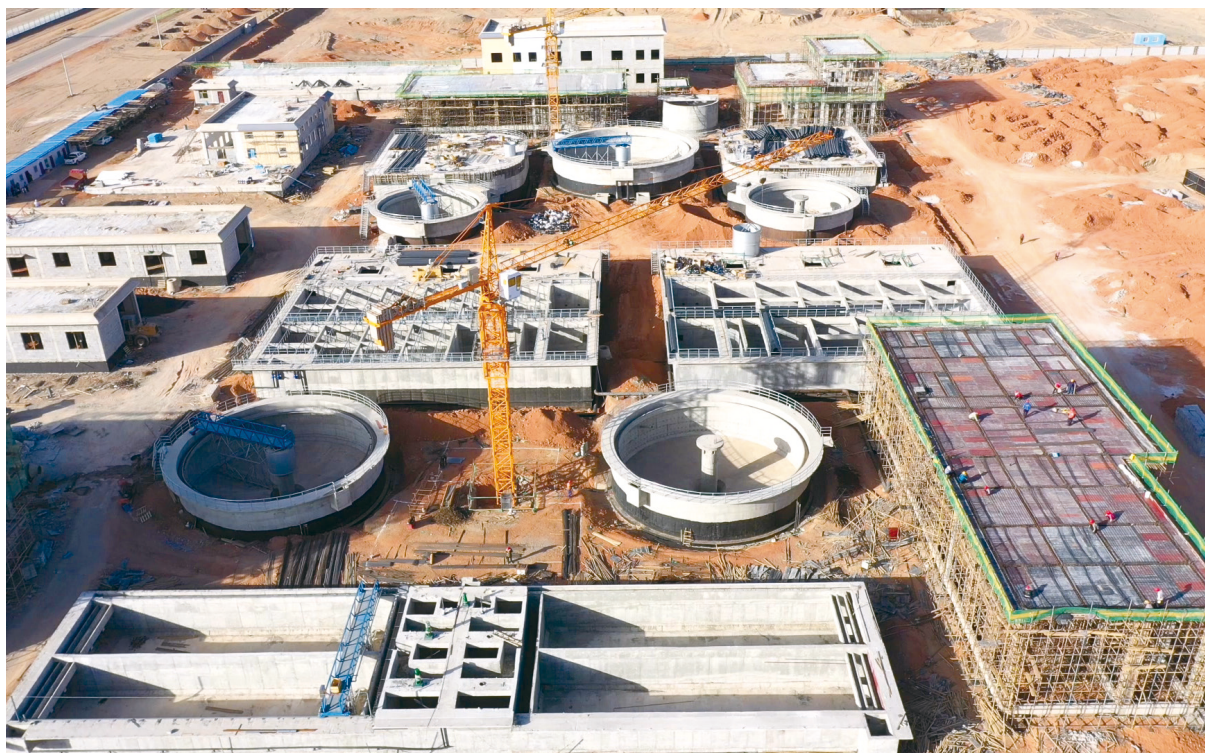
建设中的柳沟工业污水处理厂
