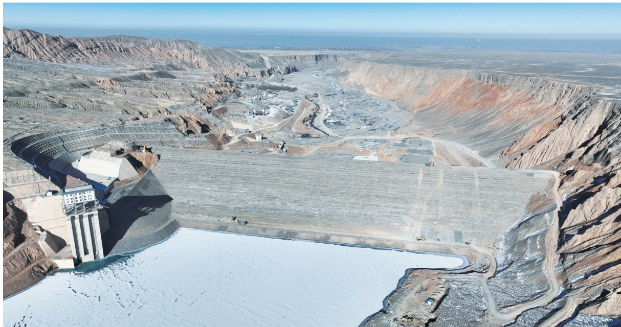
建设中的洪水河水库
