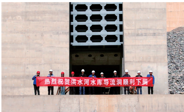
10月11日，洪水河水库导流洞 顺利下闸 (供图：区水务局)
