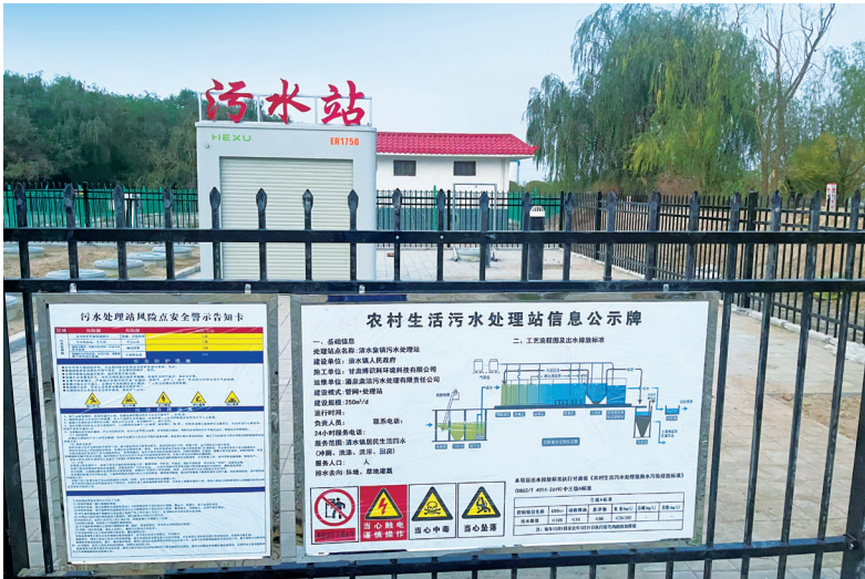
清水集镇生活污水处理站 (供图：区乡村振兴服务中心)
