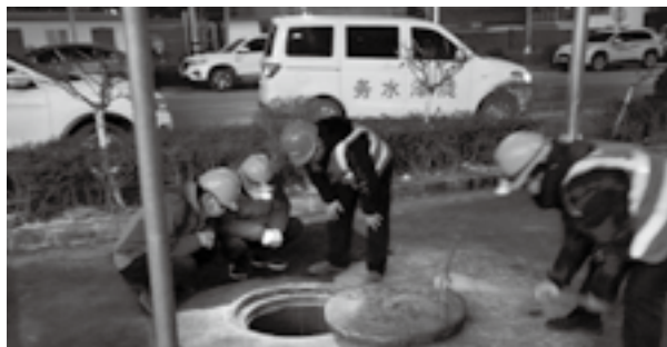
维修人员巡查供水设施
