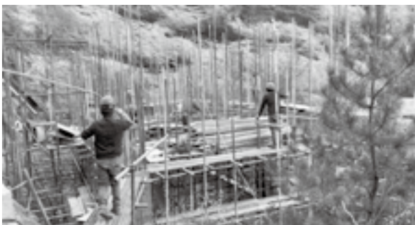
八峰崖景区旅游基础设施建设施工
