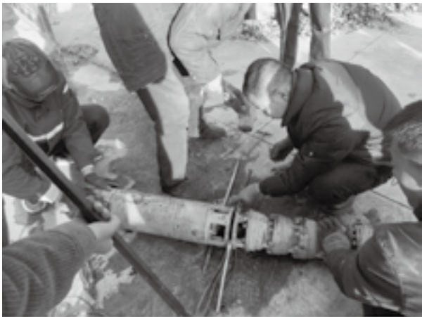
维修人员更换供水设施
