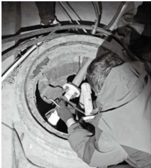
管网稽查人员检修供热管网
