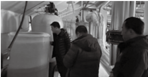
换热站运行情况检查
