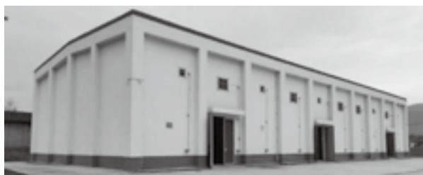
长道粮食储备库提升改造工程
