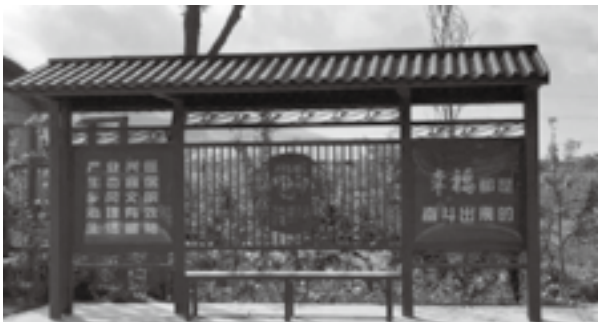
景观带、产业带、文化旅游带为一体的综合示范长廊
