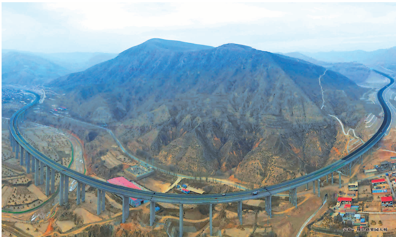
安临一级公路果园大桥
