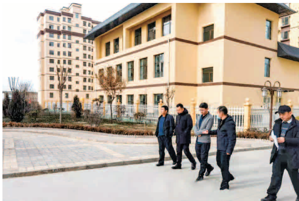
河滩棚户区改造项目现场勘查
