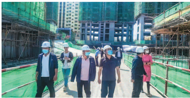
对棚户区改造项目进行建筑安全隐患排查
