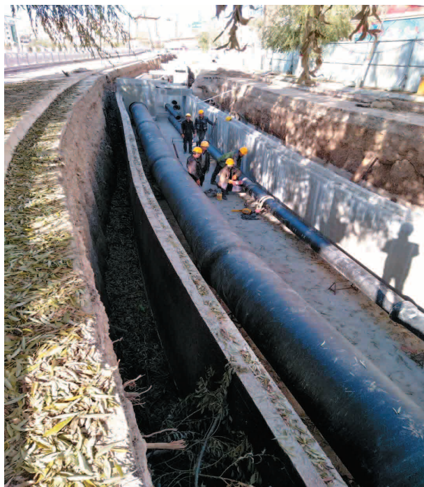
县城给排水管网改扩建工程
