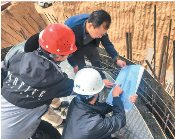
新农村污水处理厂改扩建工程
