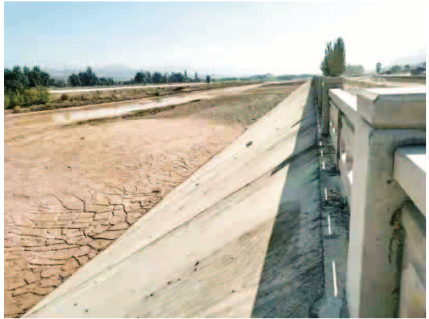
洮河防洪治理工程
