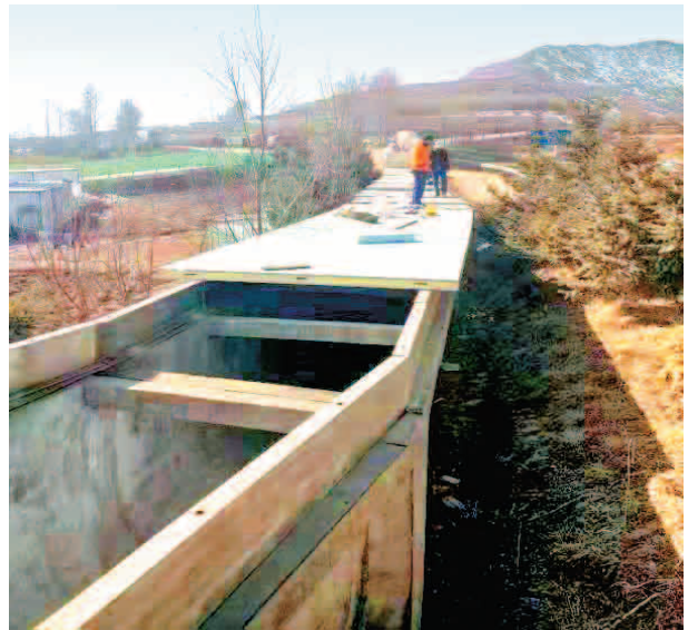
南阳渠提质增效工程
