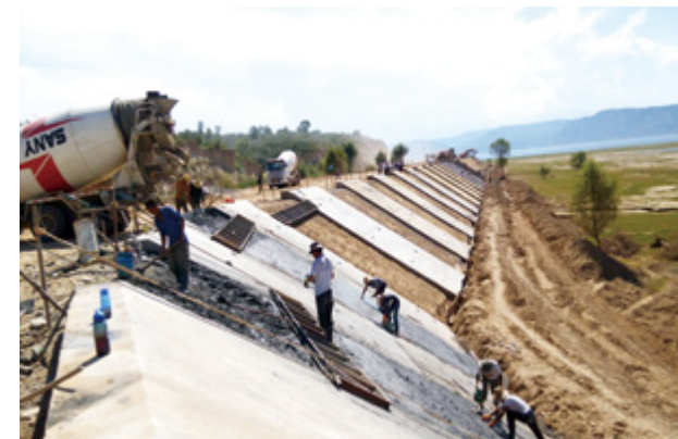
河滩祁杨库岸治理工程
