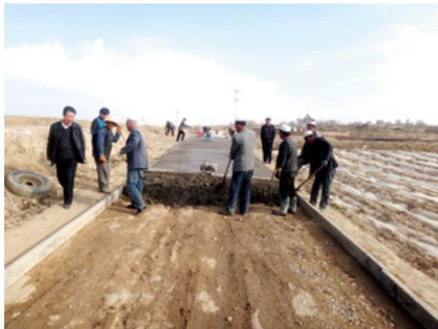
库区村道硬化
