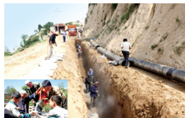
人饮工程施工现场
