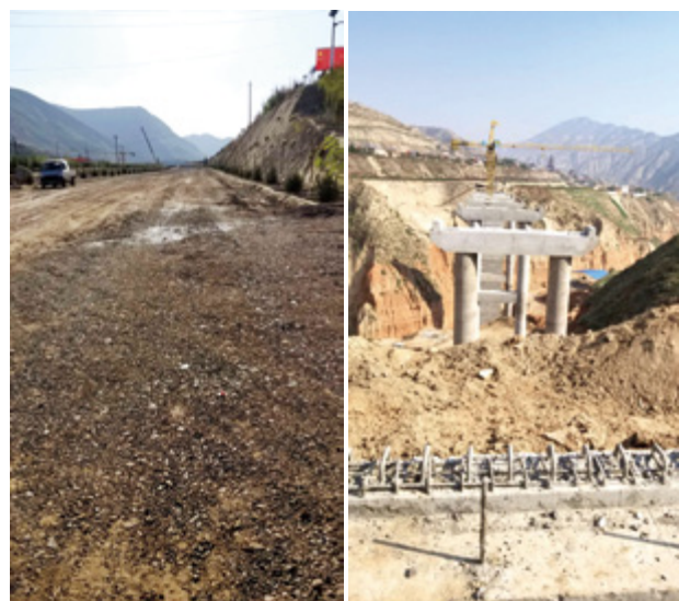
正在建设的折红路
