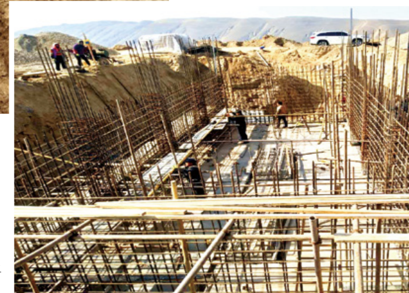
水利泵站建设
