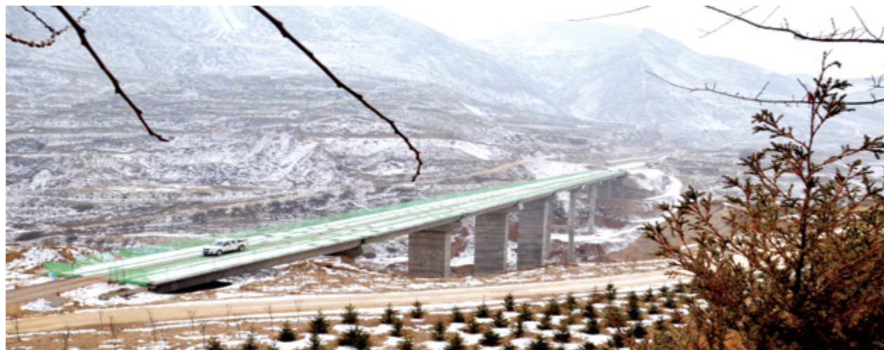
建设中的折红公路
