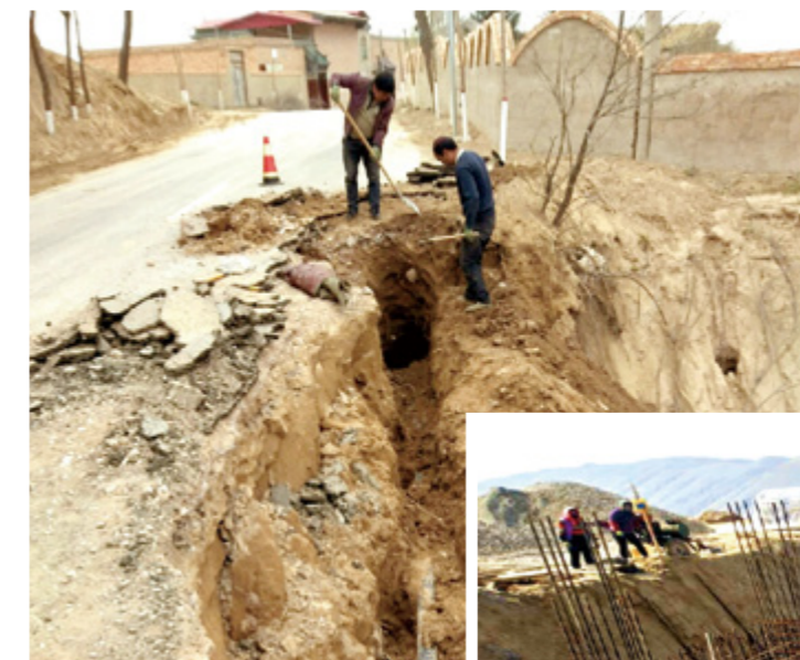
农村饮水管网维修
