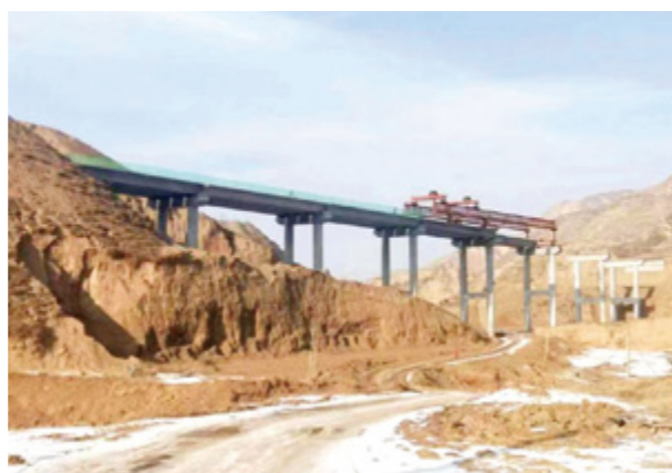
建设中的折红公路
