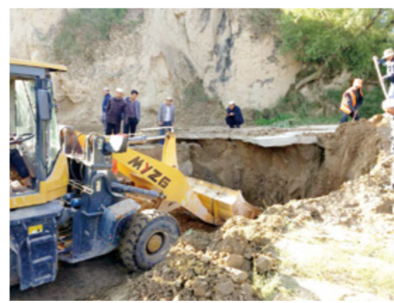
水毁道路维修
