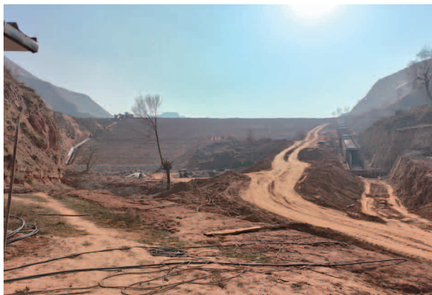
2023 年度淤地坝工程
