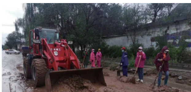
8 月 18 日，达川镇组织镇村干部及环卫工人对张岗公路道路淤泥进行全面清理
