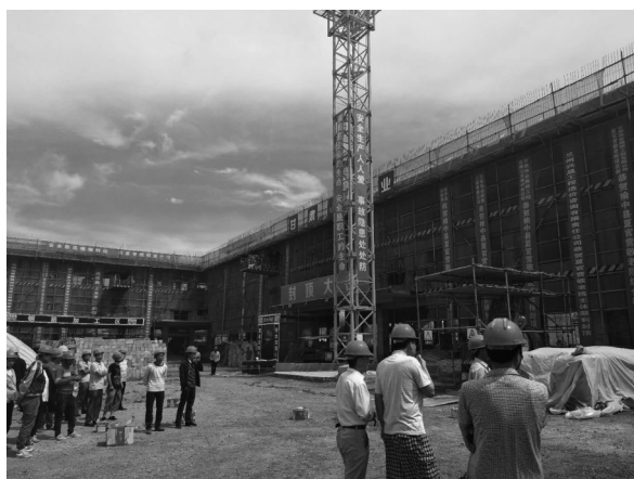
夏官营敬老院项目主体封顶
