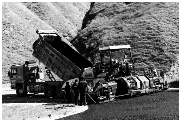
小新路升等改造现场
