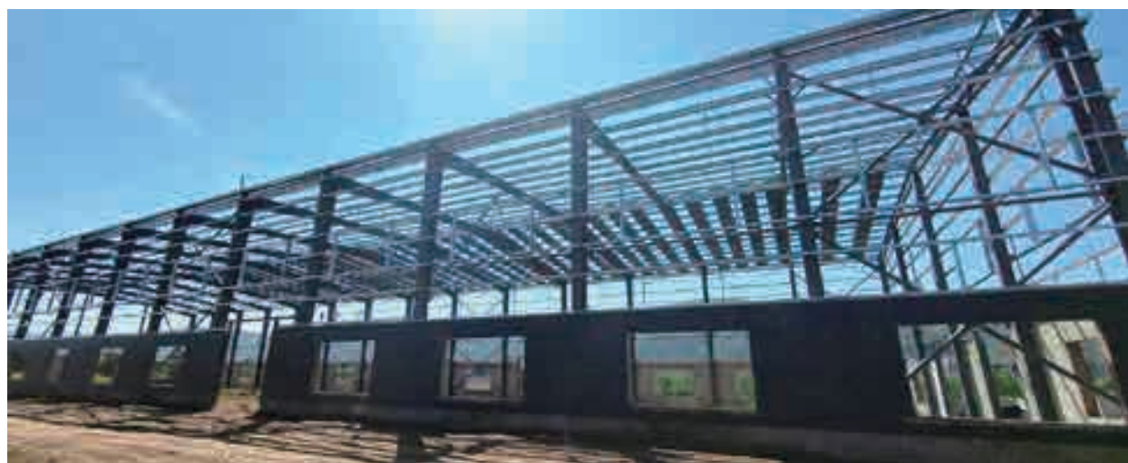
建设中的中辉利拓可降解塑料生产线项目
