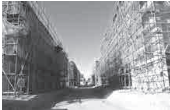
3万吨中心粮库建设项目
