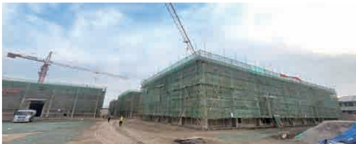
建设中的3万吨中心粮库建设项目
