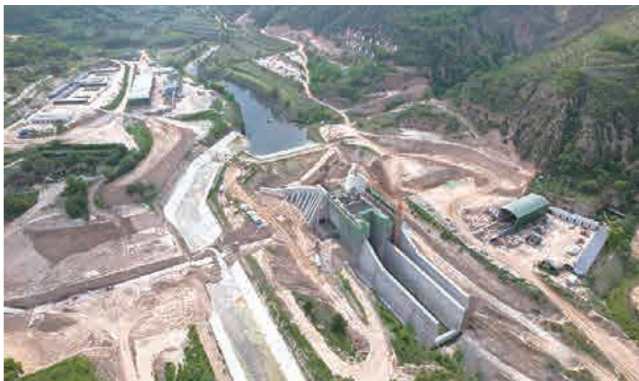
建设中的刘李河水库
