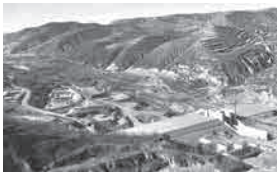
在建的刘李河水库
