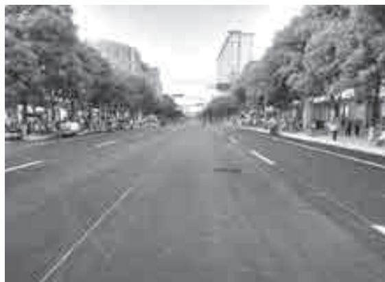
城区雨污水管网改造工程
