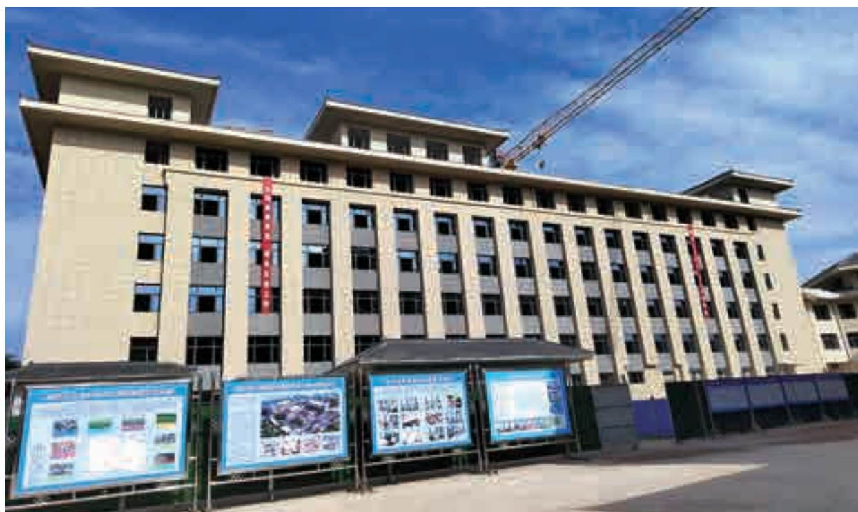
县中医院提标扩能一期项目
