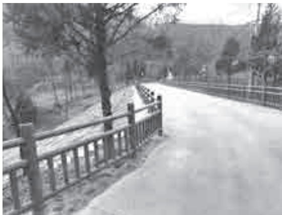
田家沟 Z6 中型淤地坝“回变”改革综合治理工程
