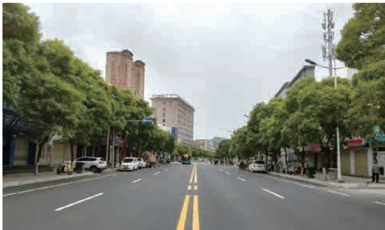
年内实施的城区雨污水管网改造工程
