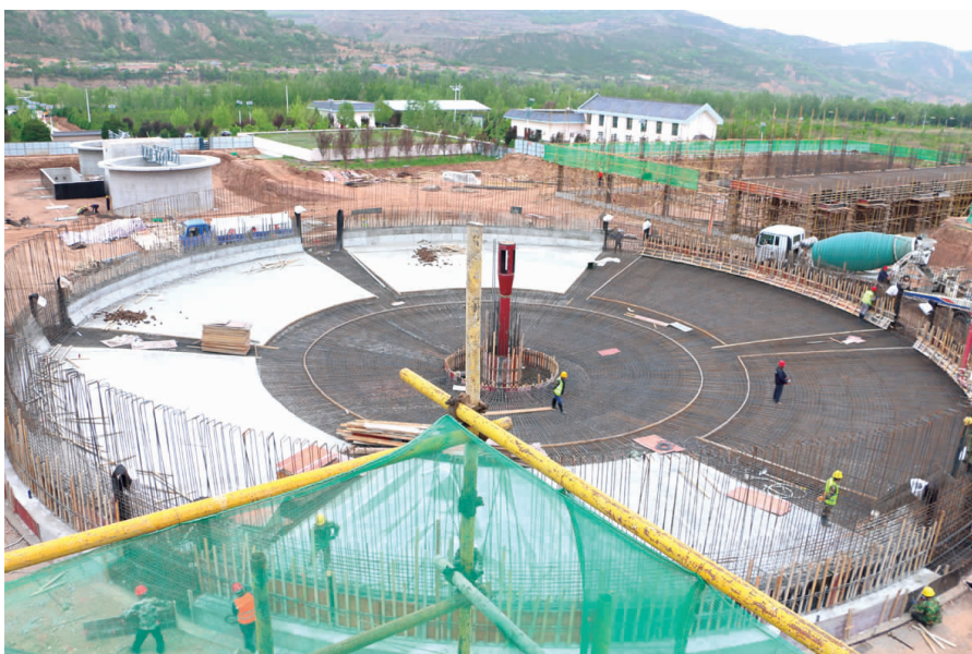
泾河流域水资源节约利用平凉中心城区供水保障工程建设现场
