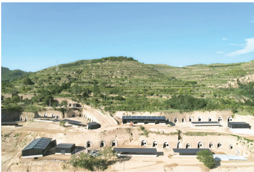
四十里铺镇庙底下村窑洞养牛基地
