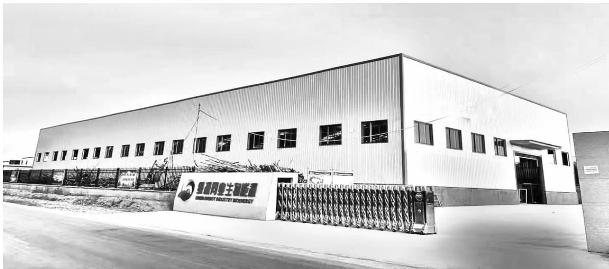
绿源同业生物能源科技股份有限公司
