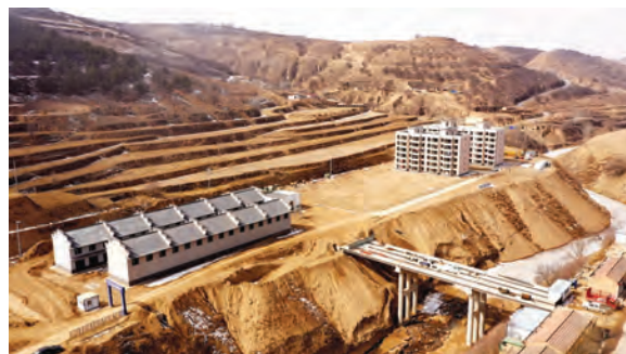
乔川乡生态移民安置点工程
