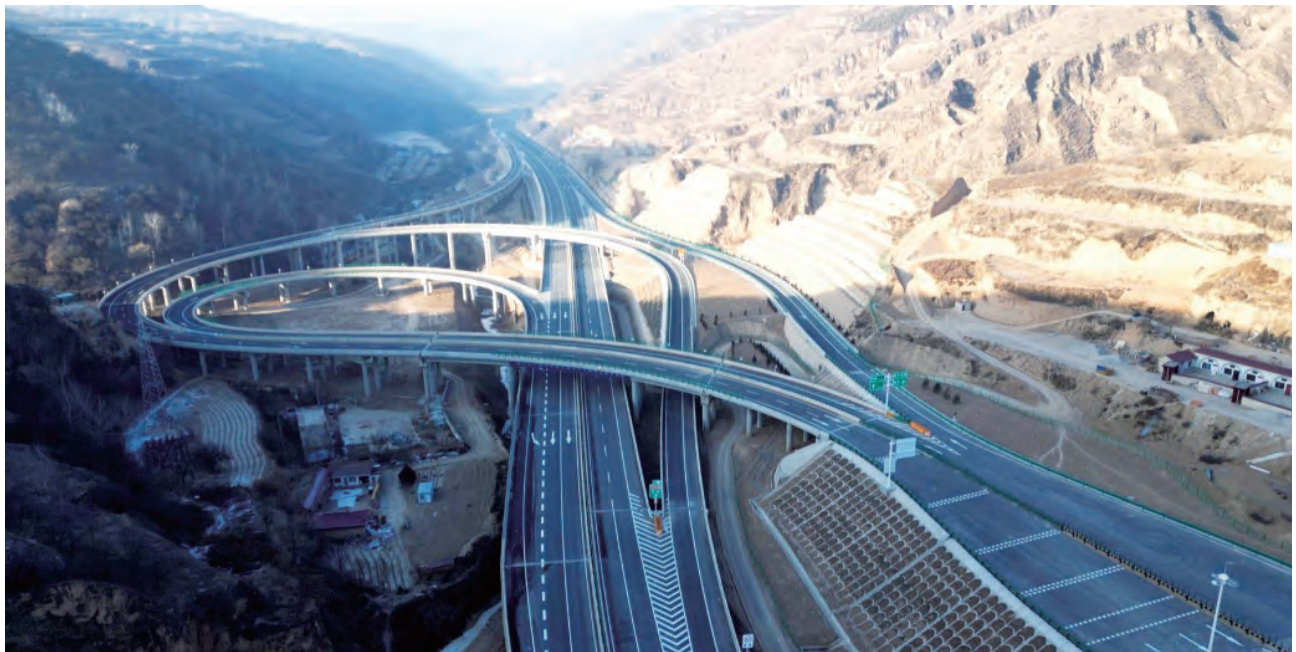
▲ 12月26日，G244线打扮梁（陕甘界）至庆城段公路通车运营，华池县告别无高速公路的历史
