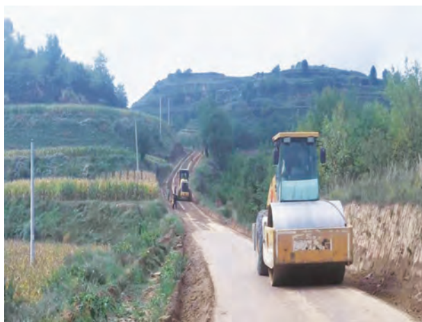
自然村组通硬化路工程水稳层铺筑
