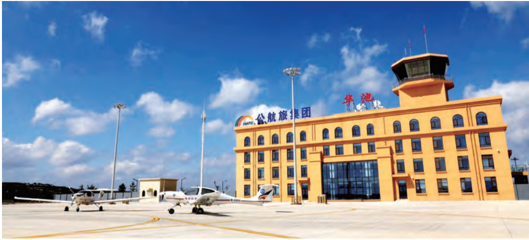
▲ 华池南梁机场
