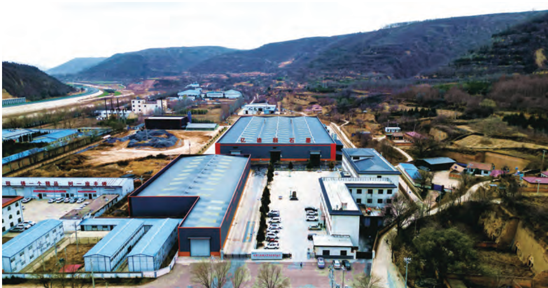
▲ 华池县石墨深加工项目
