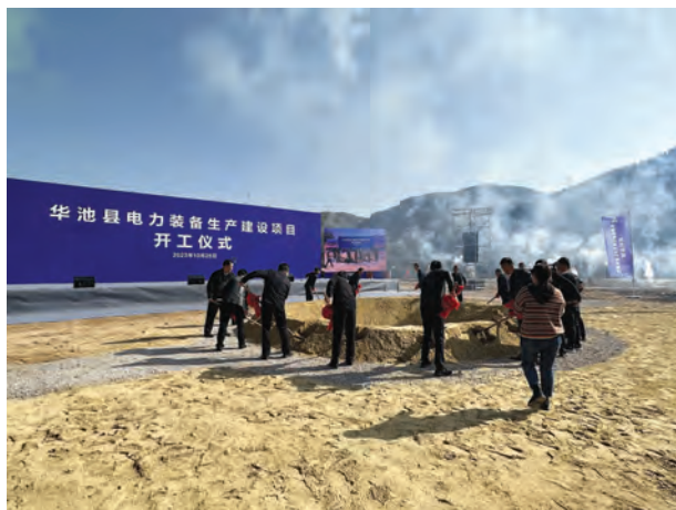
10 月 26 日，华池县电力装备生产建设项目开工
