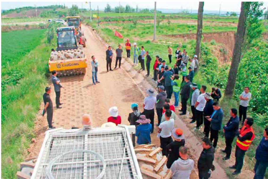
农村公路建设黄土固化技术培训（环县交通运输局 提供）
