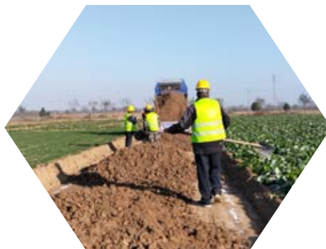
2023年11月5日，宁县中村镇组织农业技术人员在秦店村高标准农田建设项目施工现场开展作业
