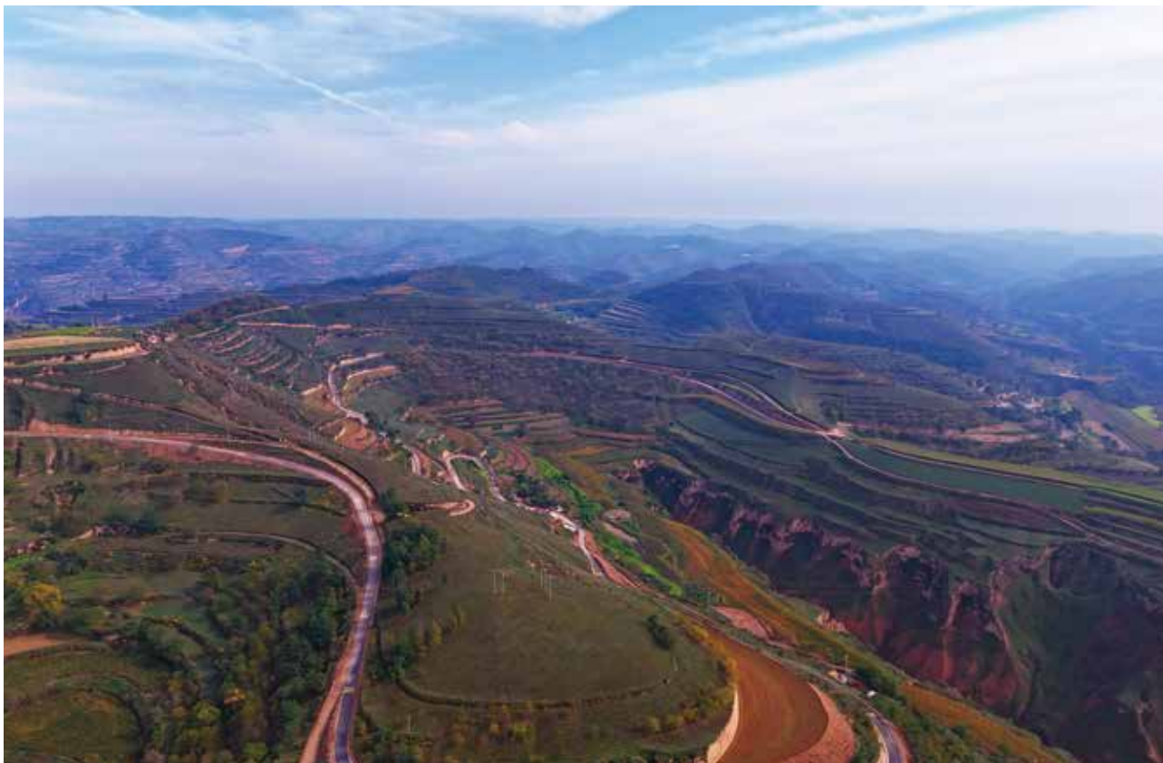
通组硬化路（土桥乡 供图）
