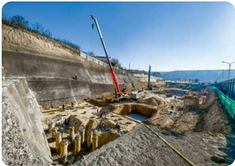
2024年4月，施工中的庆城县金祥苑城市综合体建设项目。 （凤北建设服务中心 供图）
