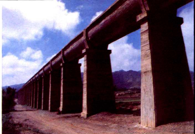
壮观的刘川电灌工程七号渡槽
