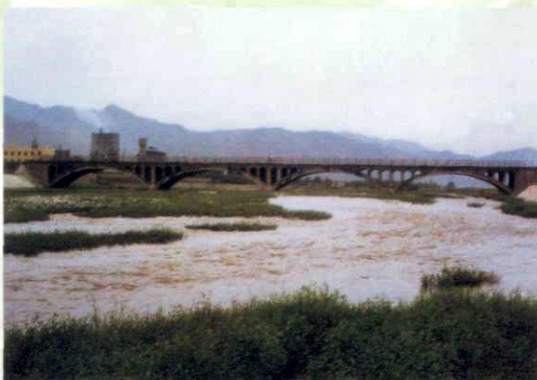
漳河公路大桥
