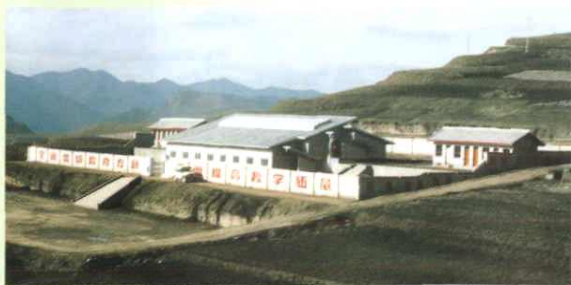
金钟斜坡希望小学
