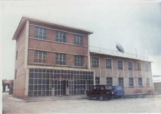
玛曲县气象站办公楼
