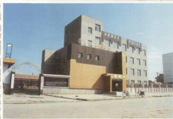
玛曲县农业银行办公大楼
