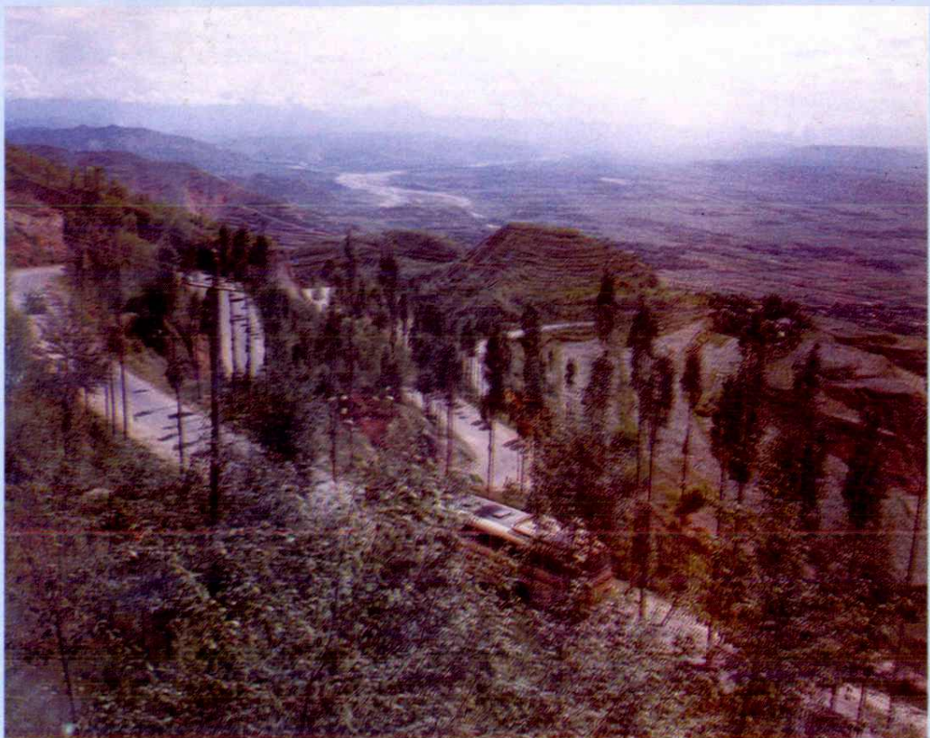
东大坡盘山公路
