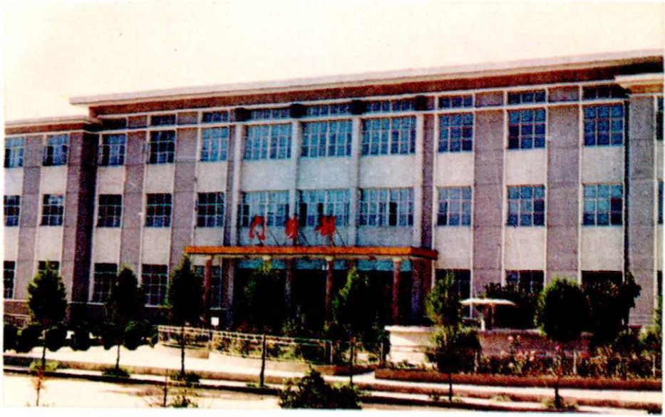
静宁县医院门诊部
