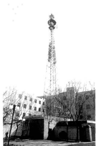
县移动公司移动通信塔
