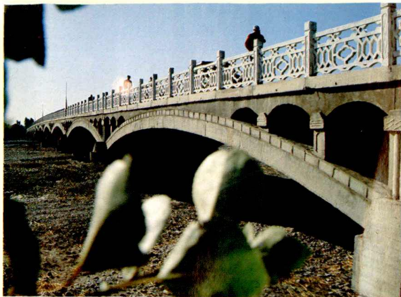
张(掖)肃(南)公路黑河大桥
