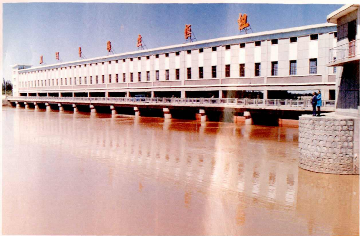
黑河草滩庄水利枢纽工程
