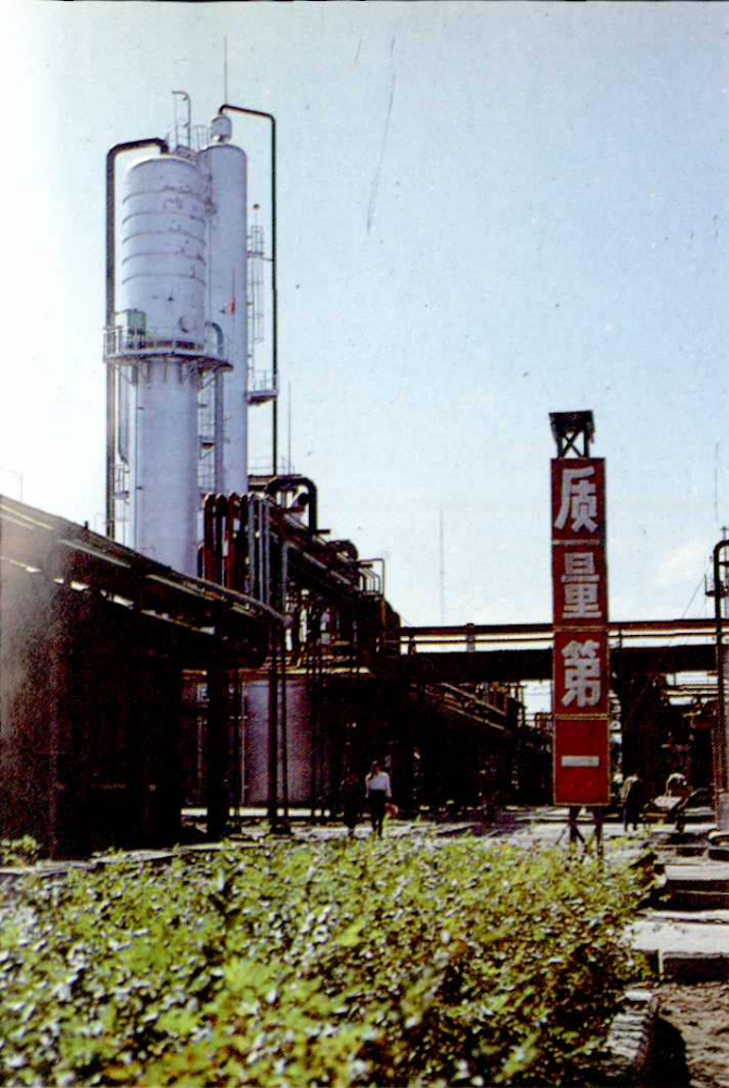
农业银行支持兴建的张掖化肥厂 尿素生产改造工程
