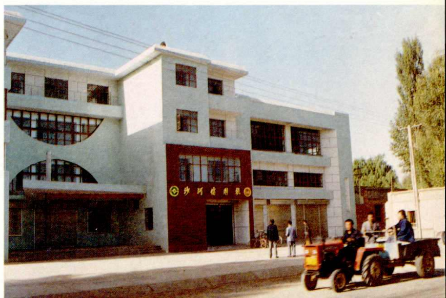
临泽县沙河信用社 的营业楼
