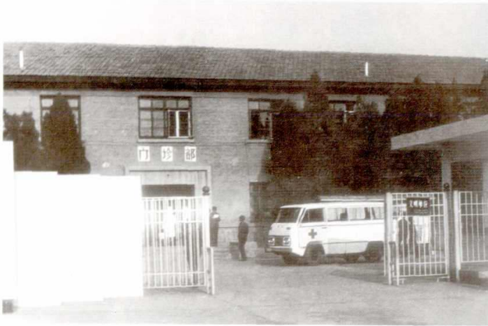
1957年医院门诊楼
