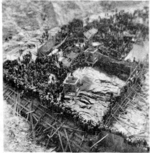
大坝第一块混凝土浇筑
