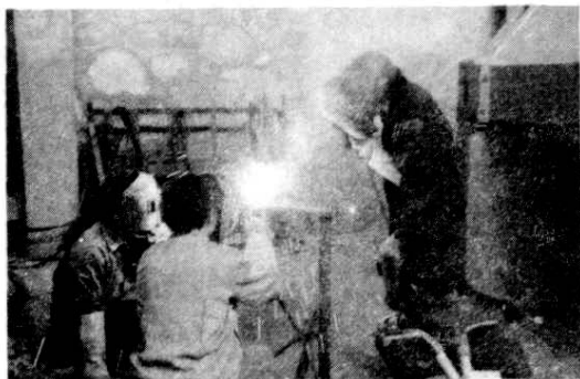
现场焊接技术培训
