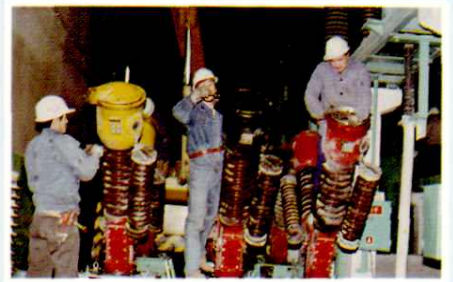
高压开关检修
