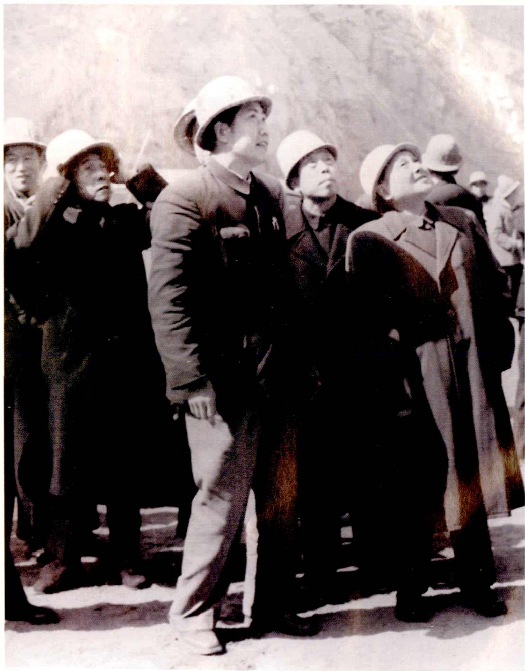
1966年3月，中共中央政治局常委、总书记邓小平(右一)在国务院副总理李富春等陪同下到刘家峡水电站工地视察
